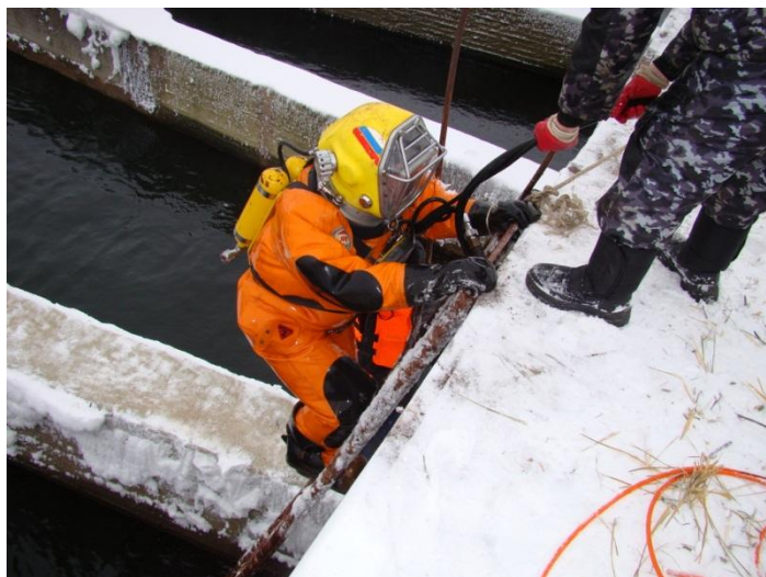
Рис. 7. Спуск водолаза в сифонный колодец водовода по переносному трапу
